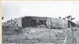
BLOCKHAUS À GRUISSAN, VERS 1945 A. T. Août 1974 312
