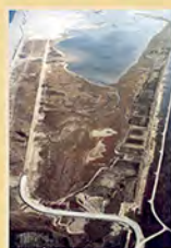
LE CHANTIER, VERS 1966 A. S. Aude 1174/117
