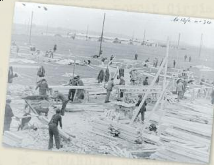
Construction des baraquements, 12 février 1939, photographie Rougé, Carcassonne.
