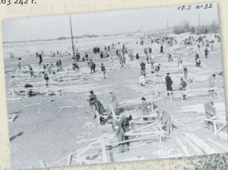
Construction des baraquements, 18 février 1939, photographie Rougé, Carcassonne.
