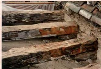
Engoulants des poutres lors de la découverte de la charpente
