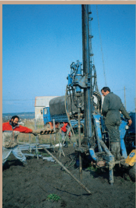
Carottage profond (~ 20 m) pour l'obtention d'une colonne de sédiments en vue d'une analyse sédimentologique palynologique et malacologique Lagune du Petit Castelou (Narbonne), 1993-1994 Cliché J. Guillaime
