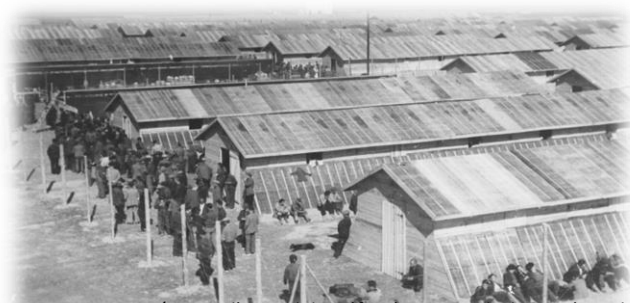
2F100818_076 / Camp d'accueil des réfugiés espagnols du Pigné, sur la commune de Montréal, dit camp de Bram.- Construction et aménagements. (février-mai 1939)
