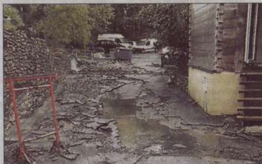
Dégât partiel de voirie dans le village.
