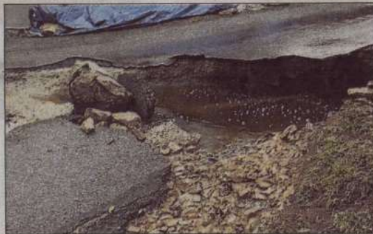
Un cratère important sur le lieu de la fontaine au Villaret.
