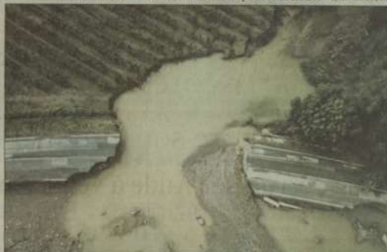
Le torrent d'eau et de boues a tout emporté sur son passage (Villermoustaussou).
