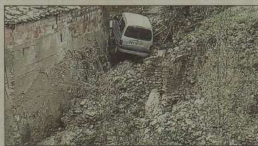
F.P. ▶ Une rue ensevelie sous des tonnes de pierres et de boue.
